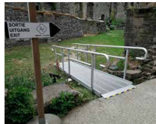
Oprijplatform openbaar gebouw Villers-la-Ville
